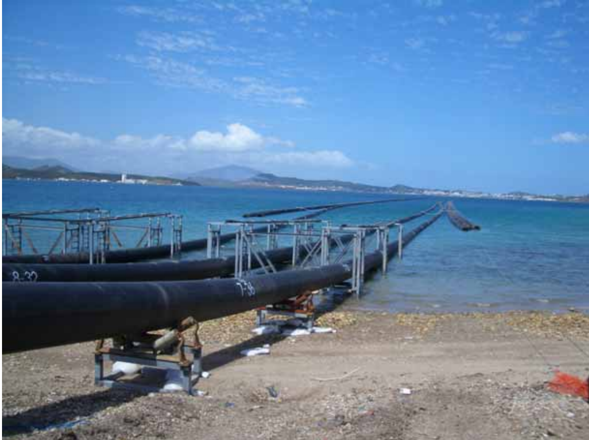
Figure 2: Sections soudées puis stockées en flottaison
