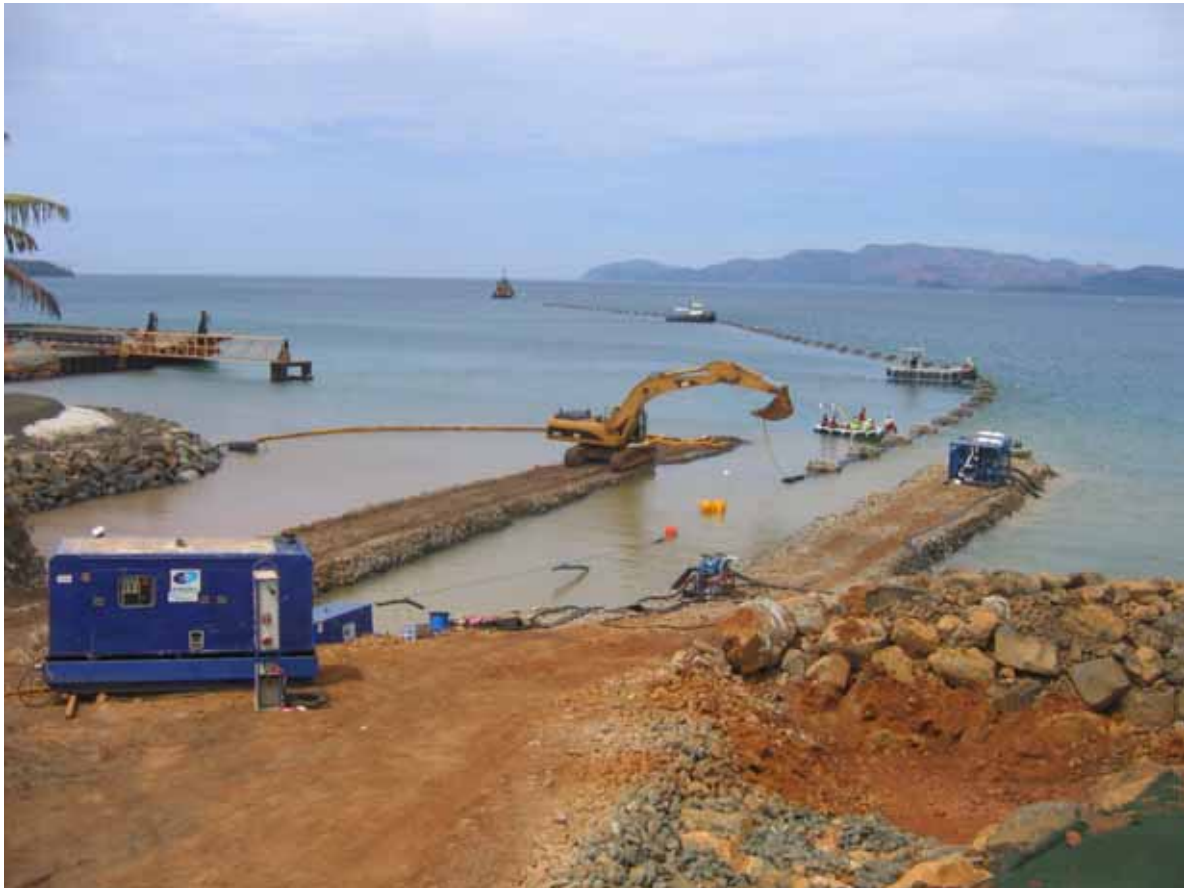
Figure 5: Première section arrivant à terre en Baie de Prony.
