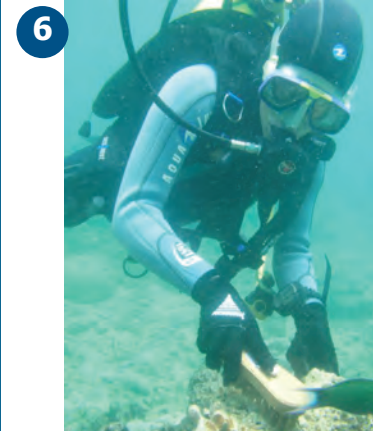
6 Une fois l'emplacement choisi avec précision, le substrat souvent recouvert d'algues est nettoyé à l'aide d'une brosse métallique afin de faciliter l'adhérence du ciment.
